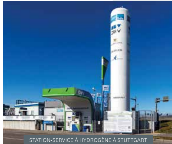
STATION-SERVICE À HYDROGÈNE À STUTTART
