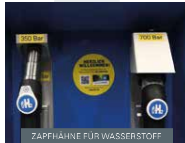
ZAPFHÄHNE FÜR WASSERSTOFF
